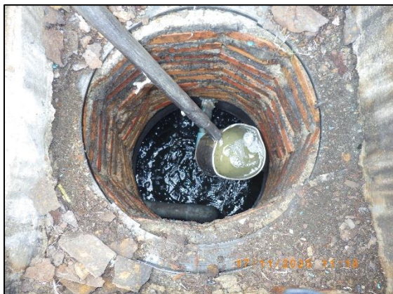
(2) บ่อตรวจสอบคุณภาพน้ำทั้งหลังจากจากระบบบำบัดน้ำเสีย ตึก A
